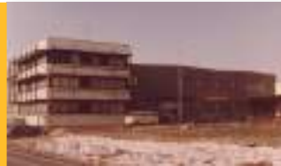
Errichtung eines Verwaltungsgebäudes sowie einer Lager- und Versandhalle
